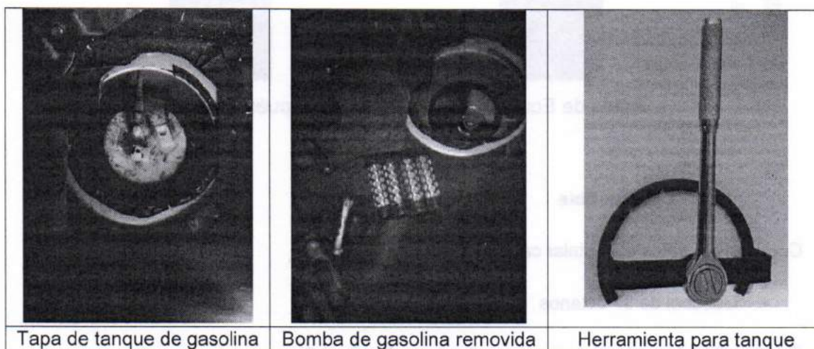
Figura 2. Instalación de catalizadores EcoEvol C.
